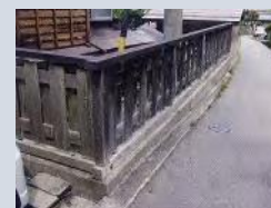
雨水侵入防止壁の例
