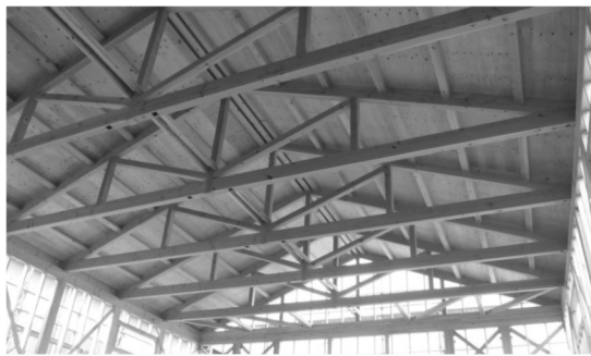
流通製材と住宅用プレカットによる12mハッシュ山形トラス
