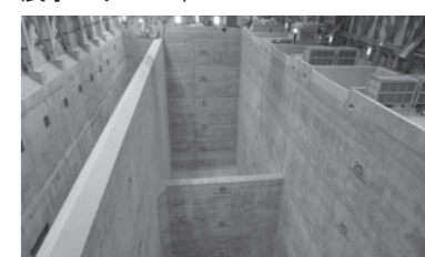
巨大なごみピット
