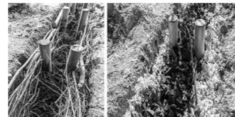
枯葉や枯れ枝に現場で出た廃材となる木屑と竹炭をブレンドし土中環境整備
