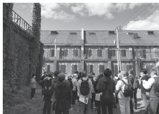
旧陸軍被服支廠倉庫
