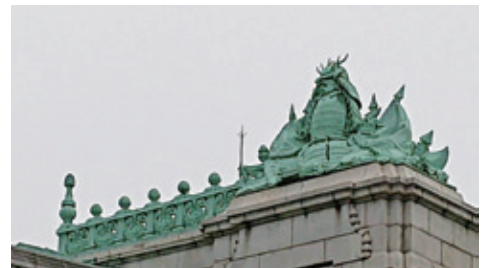
写真2 正面玄関頂部の「阿吽の鎧武者」
