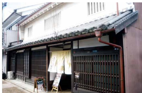
空き家の活用飲食店・宿泊施設事例(融資制度を活用)
