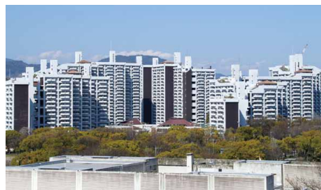
市営基町高層アパート
