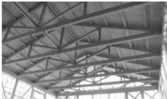
流通製材と住宅用プレカットによる12m 2 山形トラス
