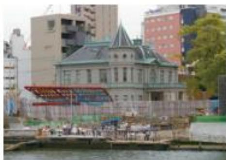
北東隅には八角塔が張り出し、南側の背面には平屋の浴室などが附属し、南東の隅2面にはベランダが設置されています。外壁の1階腰壁には白い化粧タイルを貼り、モル
