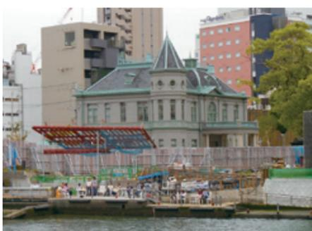
タル壁には目地を入れ、2階の窓額縁や軒蛇腹をモルタルで造り出し、石造の外観に擬しています。屋根においては中央に陸屋根を設けた寄棟形で、八角塔屋は尖塔、陸屋根以外は天然スレート葺きとなっています。内部は、主要室の床が板張り、壁は白漆喰塗腰板張り、天井は木製格縁や木骨下地漆喰塗の格縁で幾何学模様をつくり、更には各所にお洒落なレリーフや縁どりが施され、貴賓館にふさわしい内装となっています。
