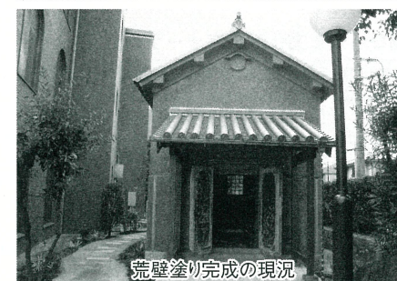
荒壁塗り完成の現況
