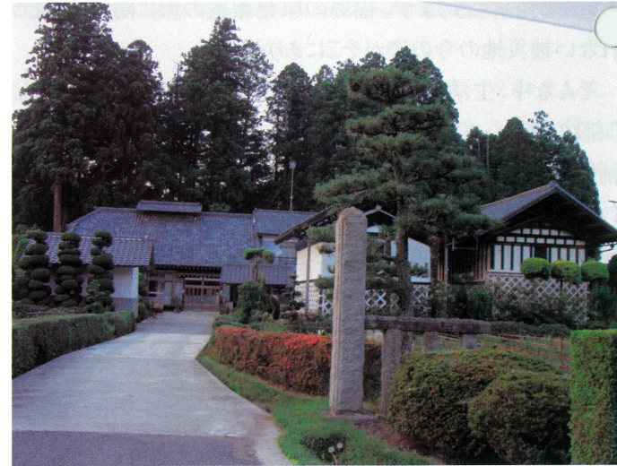
■農家住宅。兜造り・越屋根の母屋、置屋根の蔵が印象的。元は、母屋は茅葺、蔵の腰壁は木が主流。
