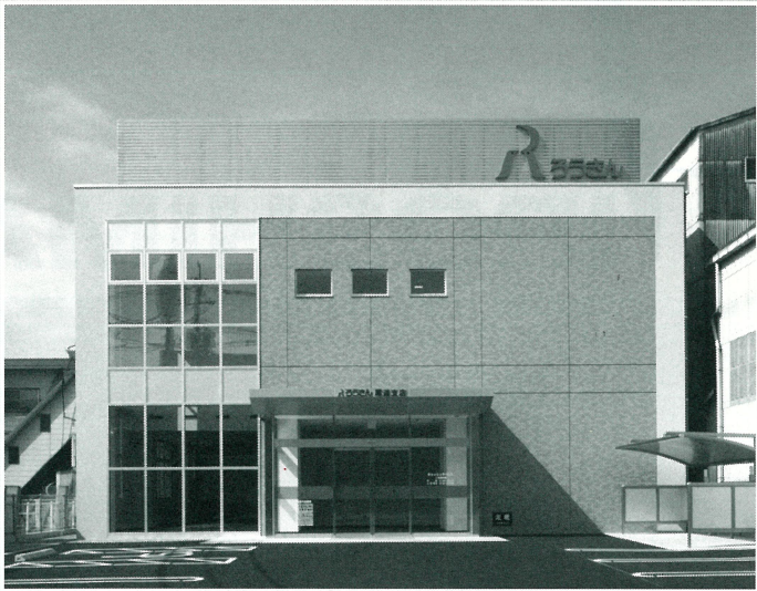
「中国労働金庫 尾道支店」新築工事
