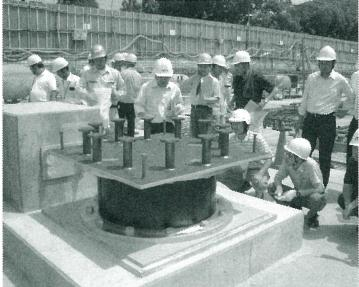
免震ゴムは震度5以下地震では作動せず、震度6の地震時に作動することでした。地震時の水平変位は約30cmで上下の躯体は50cm程の水平クリアランスを見込んでおり、設備配管などもその水平変位に追従できるような計画がなされているとのことです。
