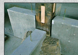
柱廻り基礎立上り
