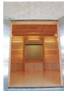
仏像（お釈迦様）と位牌を祀るための施設である。防火上の配慮からRC造が要求された仏殿と位牌堂を兼ねる当該施設が建つのは、曹洞宗の寺院本堂のある境内から水路を隔てて3m程度高くなっている住宅地に貫入し、三方を隣地に囲まれた50坪程度の広さの場所である。建物は、木造建築に由来する様式にとらわれることなく、凹凸のない化粧打ち放し仕上げのコンクリートボックスに銅板一文字葺きの宝形屋根をのせたシンプルな外観とし、周辺環境に馴染むような形状としている。静的でシンメトリカルな建物に対し、アプローチの通路や橋や階段などの外構に関わる装置は動的でアシンメトリカルな配置になるように工夫している。
