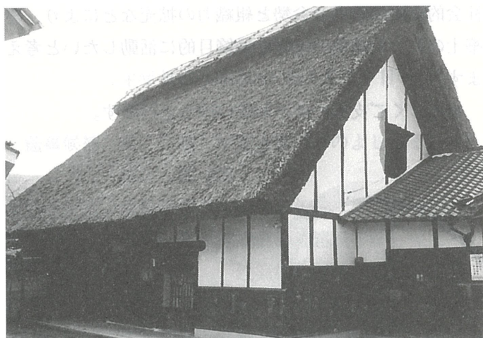
主屋南東面外観
