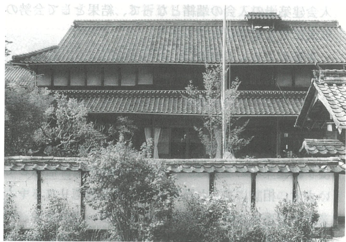
主屋 南面外観
