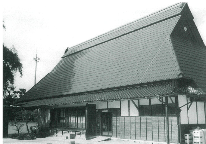
主屋南面外観
