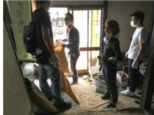
H28. 6. 25 尾道 多門亭の清掃
