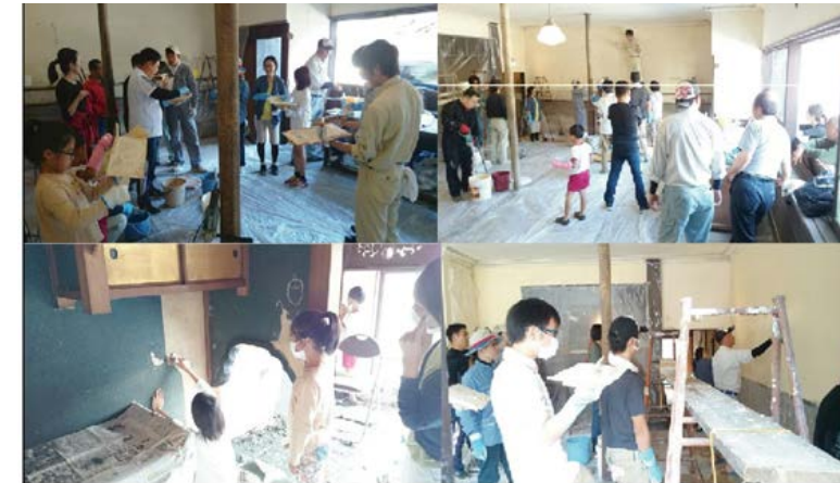
【ボランティアによる改修作業】
