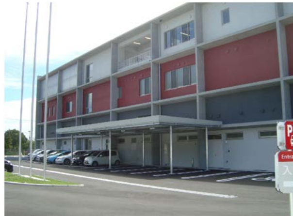
【三原市消防署新庁舎】
