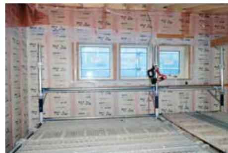
壁充填断熱 袋入り高性能GW105mm
