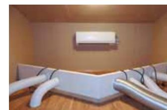
ルームエアコンによるロフトダクト式冷暖房システム 夏場にエアコンの除湿の稼働率を上げるためにロフトに設置をしています。
