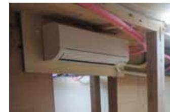
ルームエアコンによる床下エアコン暖房システム 夏にも床下の結露対策として使用します。
