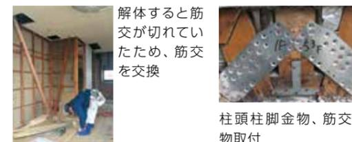
解体すると筋交が切れていたため、筋交を交換
