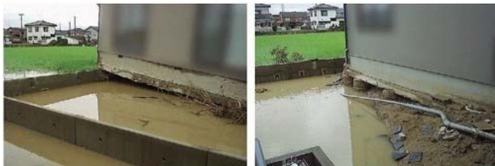
2004年新潟・福島豪雨で、堤防が決壊した場所から約100mの距離に建っていた2棟の住宅。洗掘を受けたことで、ベタ基礎の住宅（写真左）は基礎ごと流されて傾いたが、柱状改良で地盤補強していた布基礎の住宅（右）は軽微な被害で済んだ（写真：ミサワホーム総合研究所）
