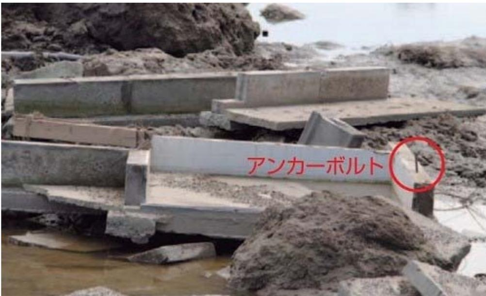
建物の上部が失われ、布基礎と土台の一部が元の敷地から離れた場所で見つかった住宅。アンカーボルトは付いていた。東日本大震災で津波を受けた住宅は基礎が比較的もとの敷地に残っていたが、今回は基礎ごとなくなっている住宅が目についた。その理由について東京理科大学工学部土木工学科水理研究室教授の二瓶泰雄さんは、「シルト混じりの砂地盤の上を、濁流が秒速3~4mで18時間近く流れ続けたからだろう。東日本大震災の津波で洗われた時間より、ずっと長かった」と話す。常総市上三坂地区で撮影（写真：日経ホームビルダー）
