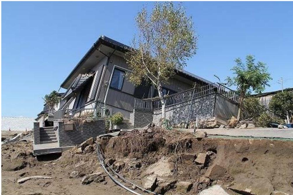
決壊した鬼怒川の堤防のすぐ近くに建つ比較的新しい平屋の住宅。裏の庭側の地盤が洗掘で大きく削られたことで建物ごと傾き、ベタ基礎が打設面から浮き上がった。正面側の地盤はアプローチの塀があったことで洗掘を免れた可能性がある。玄関は下屋が垂れ下がり、基礎が折れていた。常総市上三坂地区で撮影（写真：日経ホームビルダー）
