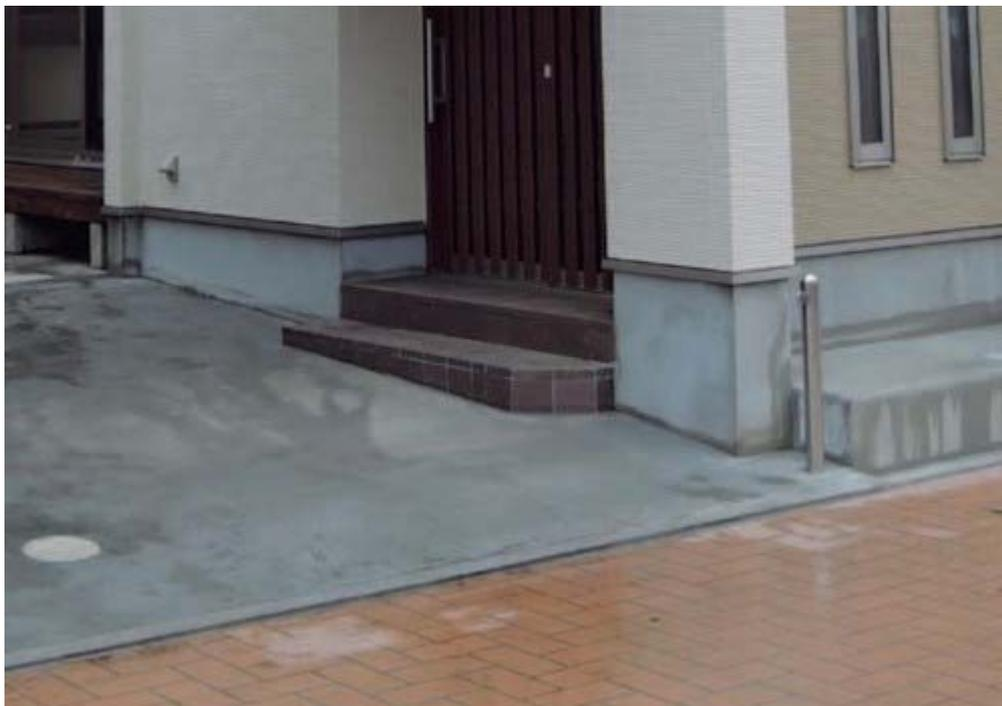
建て主の希望で、道路より地盤が高くなるよう、基礎工事で掘った土を使って盛り土していた常総市内の住宅。浸水した住宅は周囲に少なくないが、この住宅は通気パッキンより浸水深が低かったため、建物内への浸水を免れた。船本建築設計事務所（常総市）が設計し田島工務店（同）が施工を手掛けた（写真：田島工務店）
