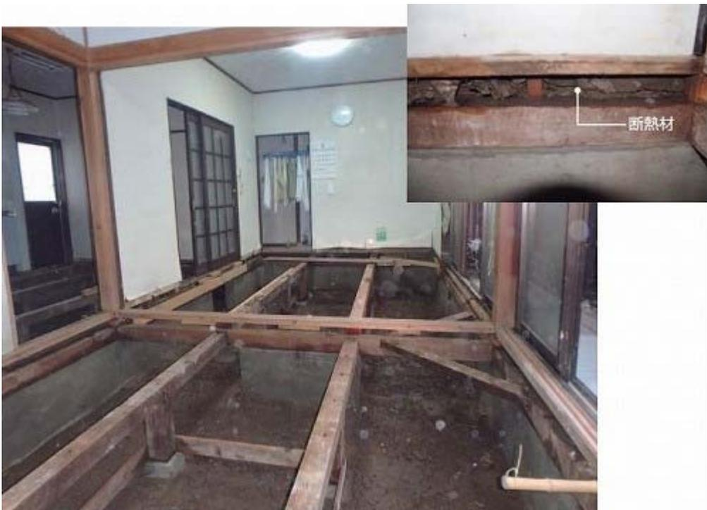
床上から約10cmの高さまで浸水した築30年の住宅。壁のラスボードと断熱材のグラスウールが泥水を吸い込み、木部がぬれていた。床材は全て剥がし、布基礎にたまった水と土を乾かしていたが、被災後10日たってもまだかなり湿っていた。常総市若宮戸地区で撮影（写真：金井工務店）
