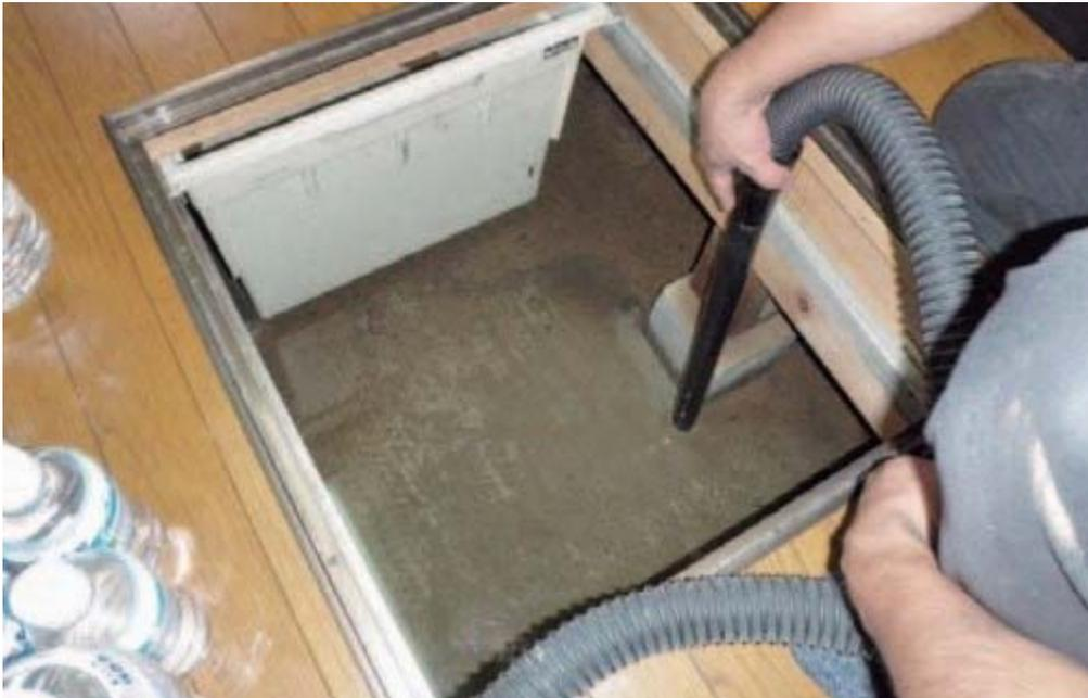
ベタ基礎の床下にたまった水と泥を、茨城県常総市の田島工務店が取り除いている様子。ポンプでは吸い上げられない水かさなので、乾湿両用掃除機を利用した。床下が人通口でつながっているので、この1カ所から床下全体の水と泥を吸い上げることができた。常総市内で撮影（写真：田島工務店）
