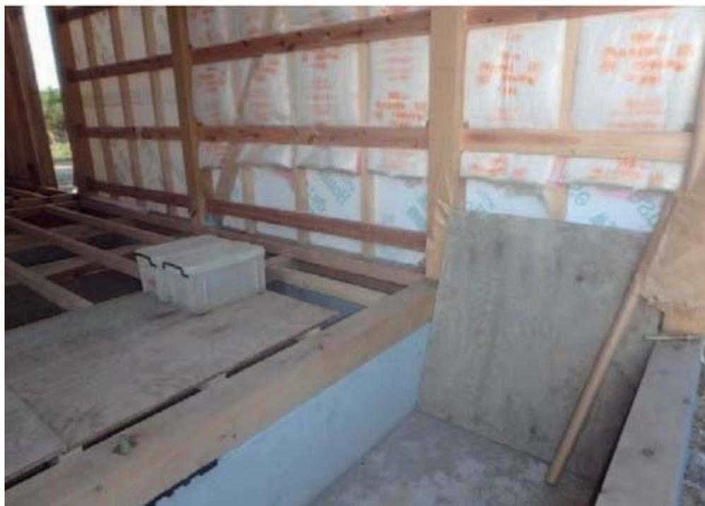
床上すれすれまで浸水した工事中の住宅。大工が断熱材の下端を切り取り、乾かしていた。基礎パッキンにも泥が付いていたので、泥を除去して通気を確保した。常総市若宮戸地区で撮影（写真：金井工務店）
