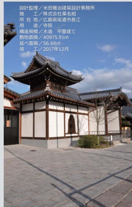
福善寺は、旧尾道街地中央の小高い丘にある。本堂と渡り廊下でつながる鼓楼玄関は、門信徒会館の一部で、庫裏ともつながって全体で延べ面積 1600 ㎡を超える木造建築となっている。築年数は一番古い旧本堂の門信徒会館で築約 390 年、増築された鼓楼玄関は築約 150 年経っている。今回は鼓楼玄関部分のみの改修で、玄関正面と太鼓楼部分は三斗組の組み物で以前と同じ土塗真壁構造の伝統工法で改修した。棟梁は福善寺の門信徒でもあり士会の会員でもある長田氏。鼓楼部分は原寸図を描き、作業場で借り組したうえで棟上げとなった。壁及び水平構面を鉄筋ブレースで補強し、組み物部分は屋内側に補強の柱梁を仕込んで金具で補強した。柱梁の外部木部は黒ベンガラ塗り、土塗真壁の室内側に断熱改修も施し、外観は以前と変わらないようにした。お寺の改修は、3 世代先に渡せる改修でなければならぬ。近年、多くのお寺で門信徒が減っている中、伝統工法によるこれだけの全面改修がなされ昔ながらの景観も守れたのは、門信徒会や工事にかかわる多くの人々との幸運なご縁のおかげであったと思う。
