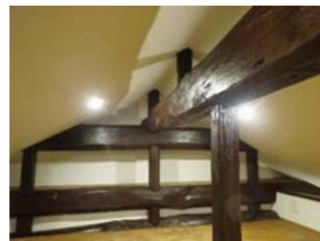
新設したロフトは小屋梁の中に落とし込み床剛性を高めた。耐震性は向上したといえます。
