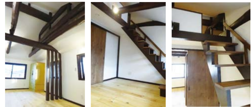
新設したロフトは小屋梁の中に落とし込み床剛性を高めた。耐震性は向上したといえます。
