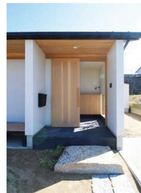
アプローチ 天井いっぱいの玄関引き戸。大きな花崗岩の踏み石とそれに続く土間は墨入りモルタル。軒裏は杉板張り。
