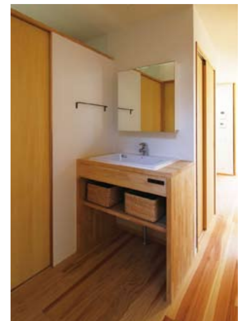
洗面 脱衣室から飛び出した洗面台。廊下の一角に洗面コーナーとして据え付けることでより自由度を高めた。
