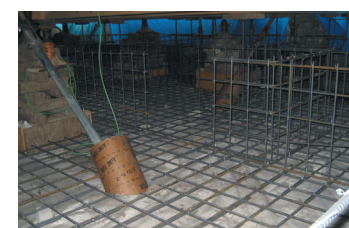
基礎配筋 べた基礎及び基礎立上り配筋完了。
