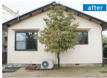
建物外観（西側）
