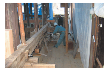
ジャッキアップ 今後予定される県道と町道の地盤面が現状より約70cm上がるため、建物をジャッキアップ。
