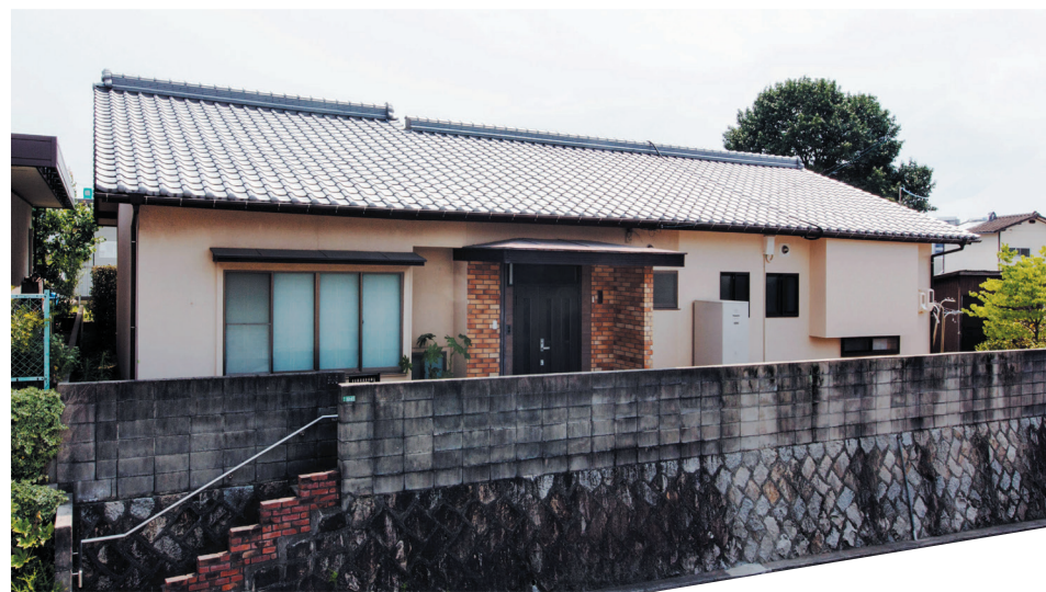
建物外観 住みつくための改修工事。瓦工事、外壁工事。
