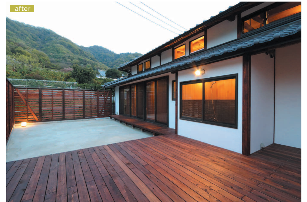
中庭・デッキ 不要になった倉庫を、柱を残して解体し木摺り塀で囲って、中庭とデッキを造った。
