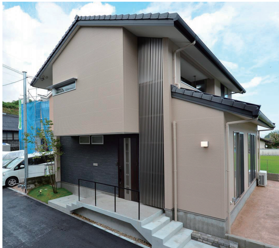
【全景】 格子がアクセントの落ち着いたトーンの外観瓦には地域材の石州瓦を使用。
