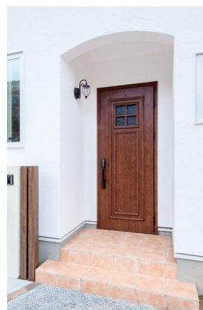
玄関ポーチ 無垢調の玄関ドア・テラコッタタイルと漆喰の調和が楽しい。
