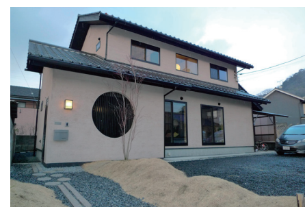
外観① 軒を深くする事によって、雨や夏の日射から建物を守ります。
