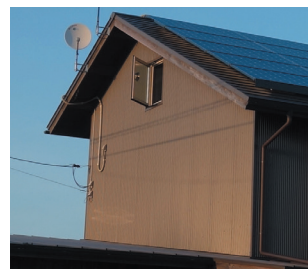
西側外壁面は窓を最小限に抑え、日射侵入による室内温度の上昇を抑えている。
