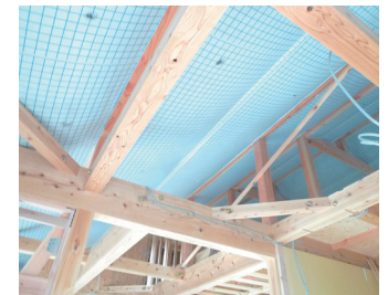
断熱材 断熱材はセルローズファイバーを使用し温湿度環境を大事にしています。
