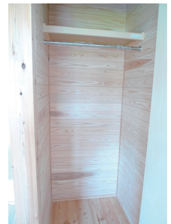
収納内部 全ての収納内部壁は広島県産の杉板を使用しています。
