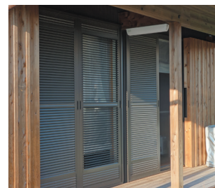
ルーバー雨戸により西日を遮蔽。夏の夜間は、ルーバーを調節し涼しい夜風を取り入れる。
