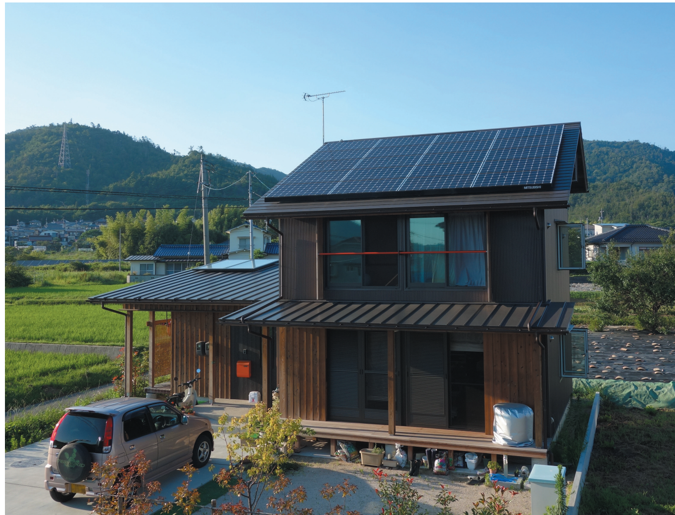
昼光利用・日射熱利用・自然風利用・日射遮蔽がしっかりと計画された外観。 太陽の熱や光も最大限利用する備えもあり、夏涼しく冬暖かい省エネ性能に優れた住まいである。
