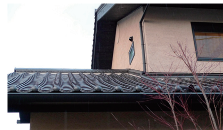
屋根 耐候性・防水性に優れた石州の和瓦を使用しています。
