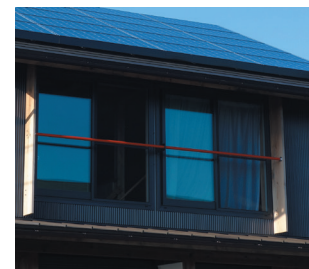
縦庇により西日を遮蔽。左右の縦庇はウィンドキャッチャーの役割も兼ねる。
