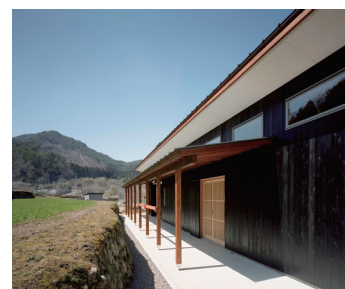
外観 大庇の下は通路兼、雨の日の作業場所となる。
