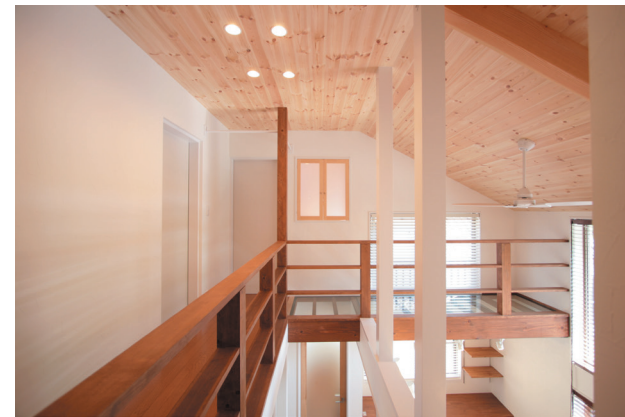
日当たりの良い吹き抜け部分にキャットウォークをつくり、冬季など洗濯物を外に干せない時の為に物干し竿も取り付けました。
